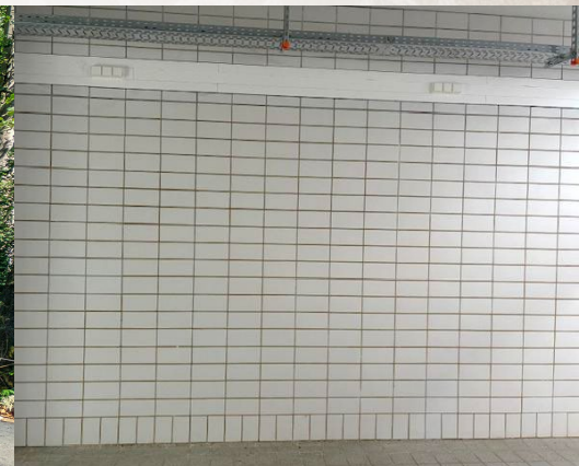
Wandfliesen im Gebäude der Futterwirtschaft
